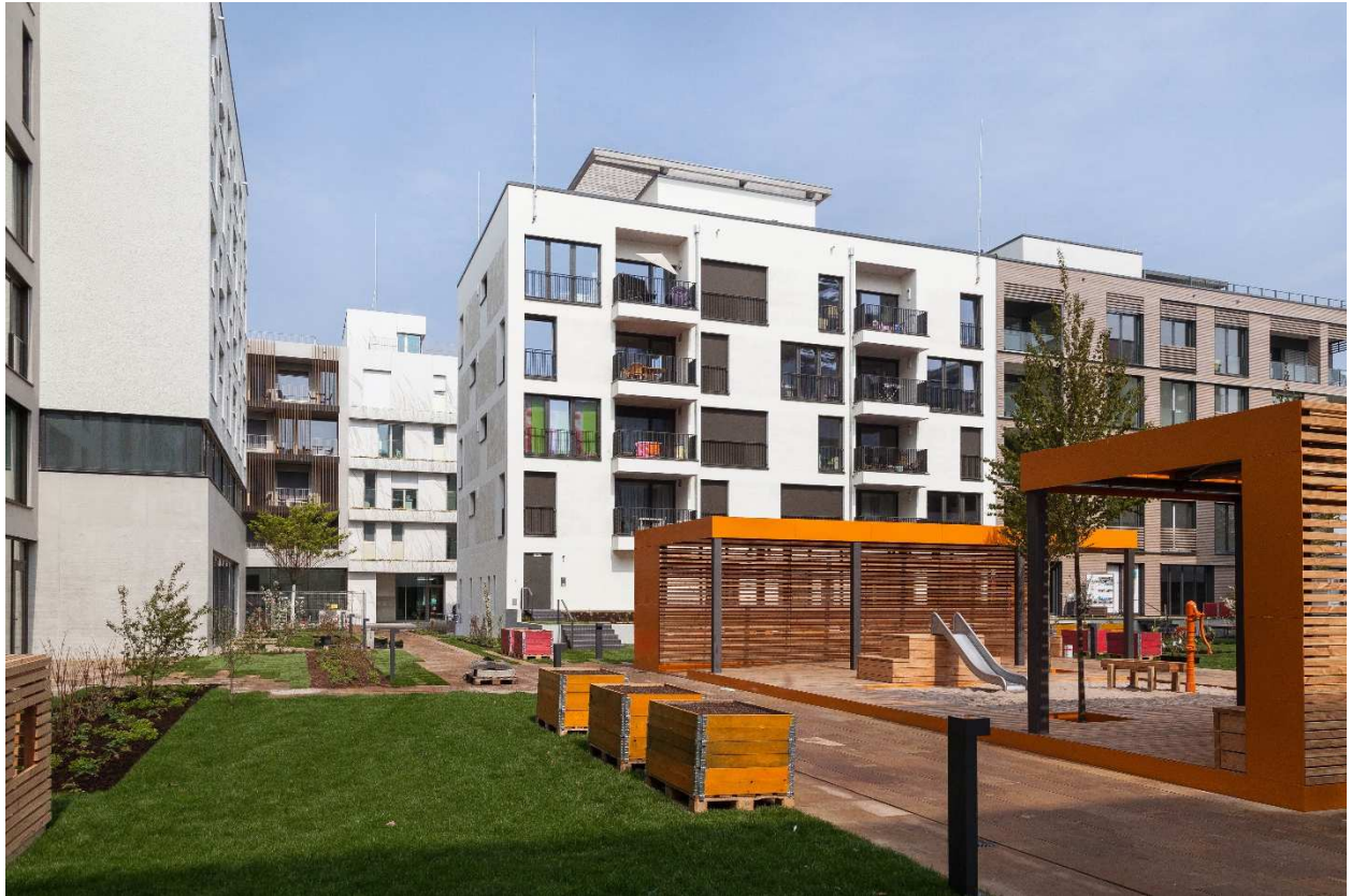
Abb. 17: 5-geschossiges Wohnhaus „FAMJU“ als Holz-Hybridkonstruktion (Foto: Stadtsiedlung Heilbronn)
