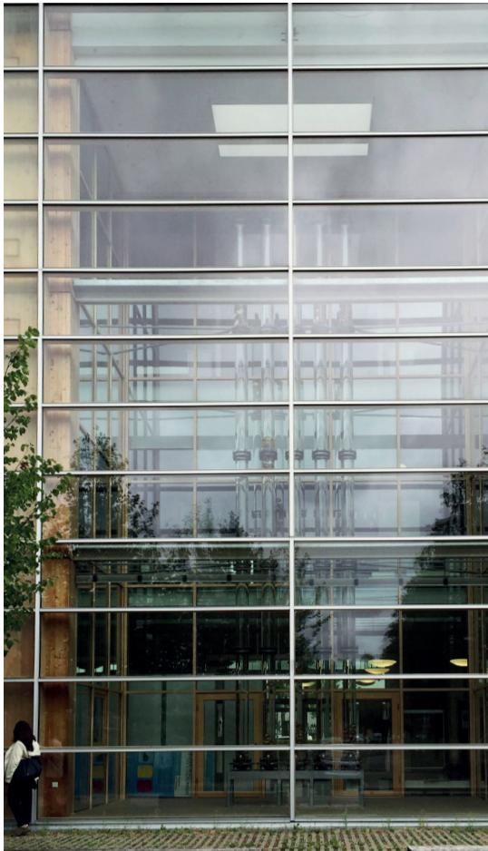
Thermische Pufferzone zur Sammlung und Speicherung solarer Wärme
