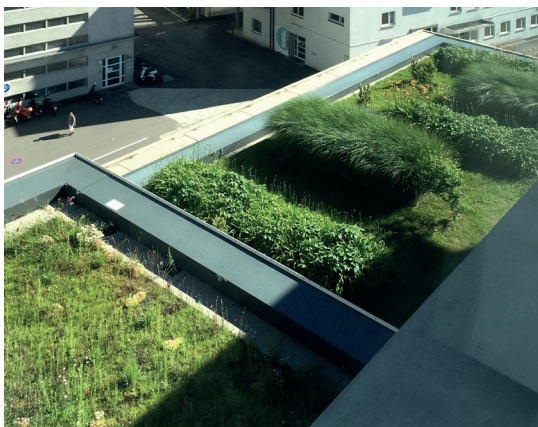
Beispiel eines intensiv begrünten Dachs
