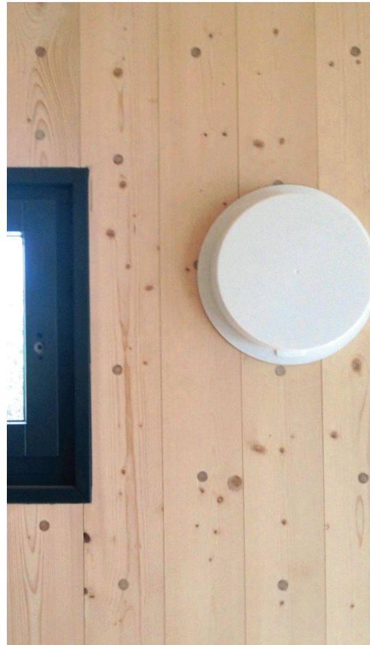
Dezentrales Lüftungsgerät mit integrierter Wärmerückgewinnung
