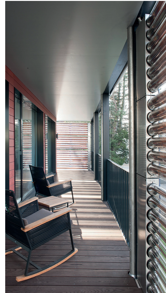
Integrierte Solarthermie in Balkonzone am Beispiel eines Dreifamilienhauses, Zürich-Höngg
