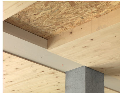
Hybrid-Konstruktion, bestehend aus Stahlbetontragwerk und Holzmassivbauelementen
