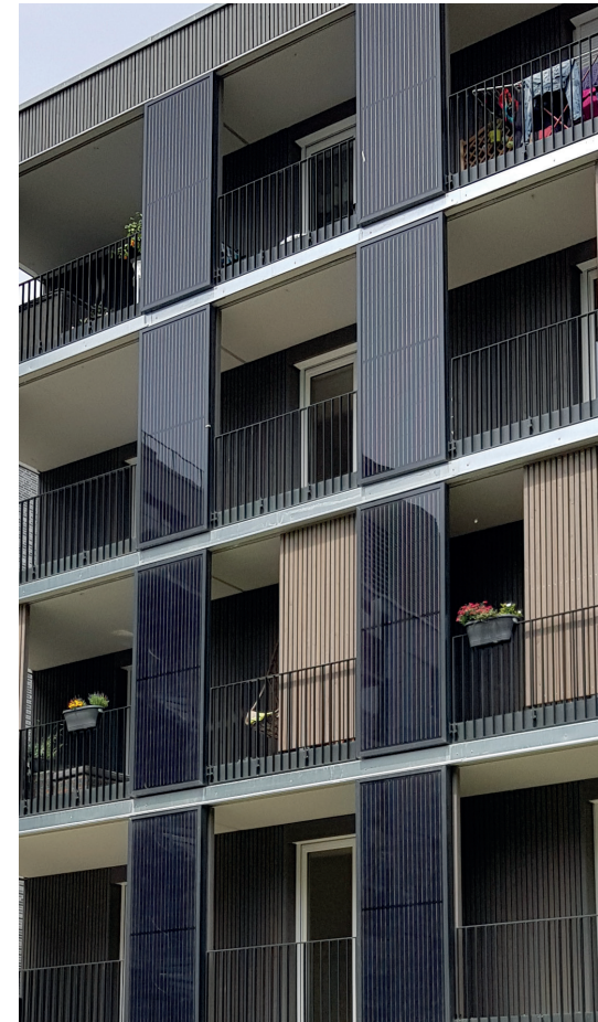
Integrierte Photovoltaik in Sonnenschutzelemente Neckar- bogen Heilbronn, 1. BA
