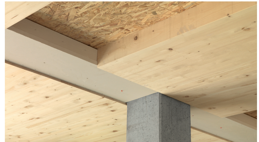
Hybrid-Konstruktion, bestehend aus Stahlbetontragwerk und Holzmassivbauelementen
