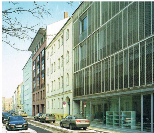
Glasfassade mit Sichtschutz/Verschattungselementen
