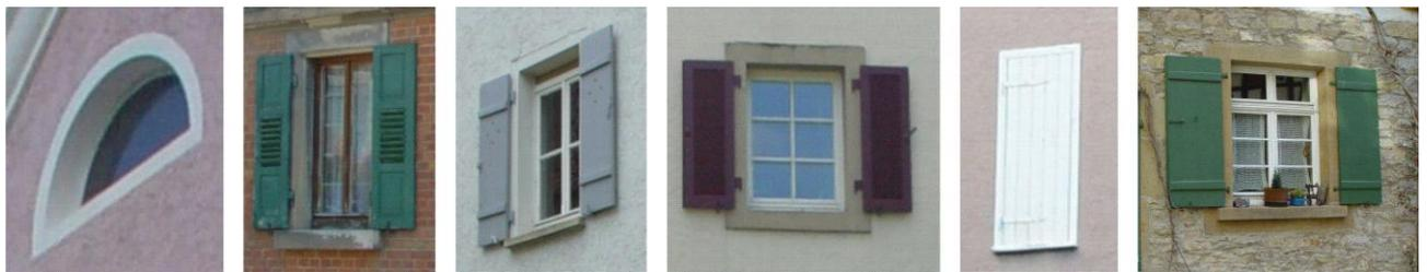
Konstruktionsbedingt hatten historische Fenster stehende Formate. Liegende Formate hätten einen aufwändigen und teuren Sturz zur Aufnahme der darüberliegenden Last benötigt. Breitere Öffnungen wurden deshalb durch fassadenbündige Pfeiler und Gesimse untergliedert.
