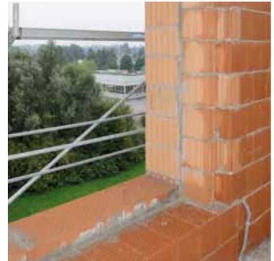
Homogene Ziegelkonstruktion ohne zusätzliche Dämmung
