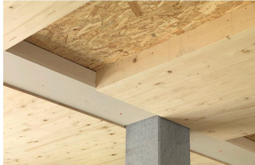
Hybrid-Konstruktion, bestehend aus Stahlbetontragwerk und Holzmassivbauelementen.
