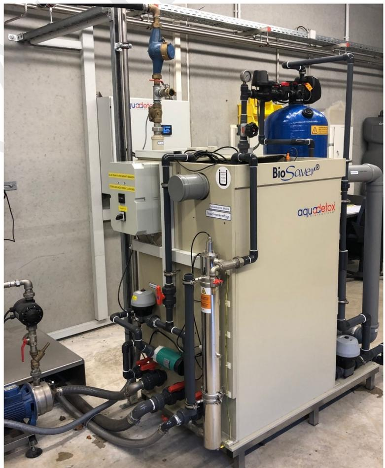
BioSaver®-System 40 mit UV-Anlage Standard
