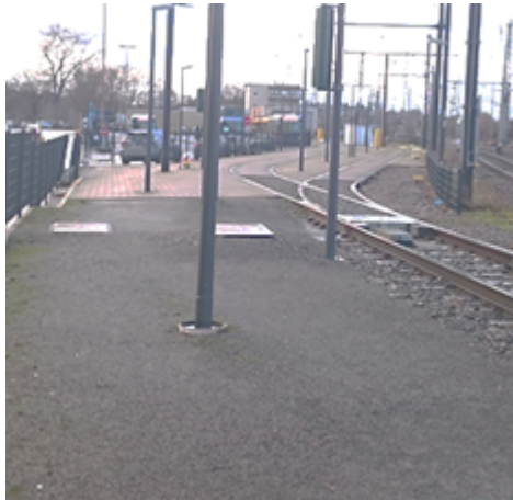
Abbildung 4: Blick aus Richtung Hbf. in Abstellanlage
