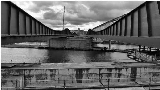
Die nördliche Hälfte der Neckarbrücke (links) wird um 21,74 Meter Richtung Süden verschoben.
