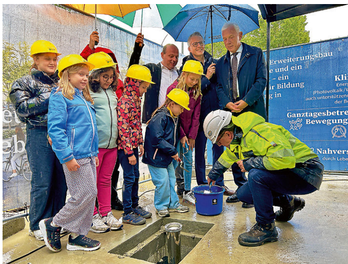
Freuen sich gemeinsam über die Grundsteinlegung, bei der Schülerinnen der Grundschule Alt-Böckingen und Stefan Hornmuth von der Firma Implenia gemeinsam zur Kelle griffen: (v. r.) Oberbürgermeister Harry Mergel, Stadtsiedlungsgeschäftsführer Dominik Buchta und Architekt Markus Happold
