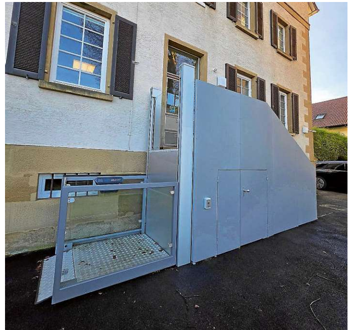
Der neue Lift am Eingang ermöglicht einen barrierefreien Zugang zur Stadtteilbibliothek Biberach Foto: Stadt Heilbronn
