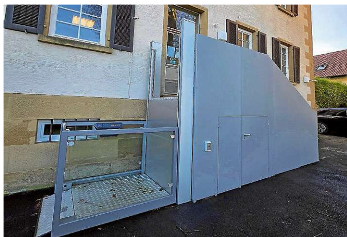
Der neue Lift am Eingang ermöglicht einen barrierefreien Zugang zur Stadtteilbibliothek Biberach. Foto: Stadt Heilbronn
