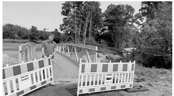
Thomas Feiert, Leiter des Amts für Straßenwesen, gibt die neue Fahrrad- und Fußgängerbrücke über den Böllinger Bach frei. Foto: Stadt Heilbronn
