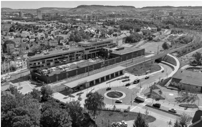
Das Bild zeigt den Mobilitätspunkt Sonnenbrunnen in Böckingen, an dem die verschiedenen Verkehrsarten wie Auto, Stadtbahn, Bus, Rad- und Fußverkehr zusammenkommen. (Foto: Stadt Heilbronn/Christina Kratzenberg)
