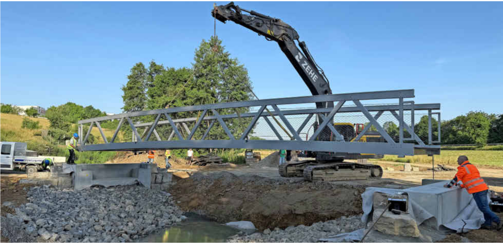
Routiniert lassen die Männer der Baufirma die knapp fünf Tonnen schwere Aluminiumbrücke am Böllinger Bach einschweben.
