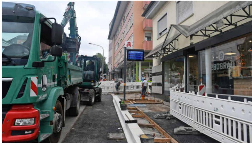
Die Haltestelle Südbahnhof ist bereits die sechste Bushaltestelle, die in diesem Jahr barrierefrei umgebaut wird. Fertiggestellt ist bereits das erhöhte weiße Busbord zum stufenlosen Einstieg. Foto: Kupper
