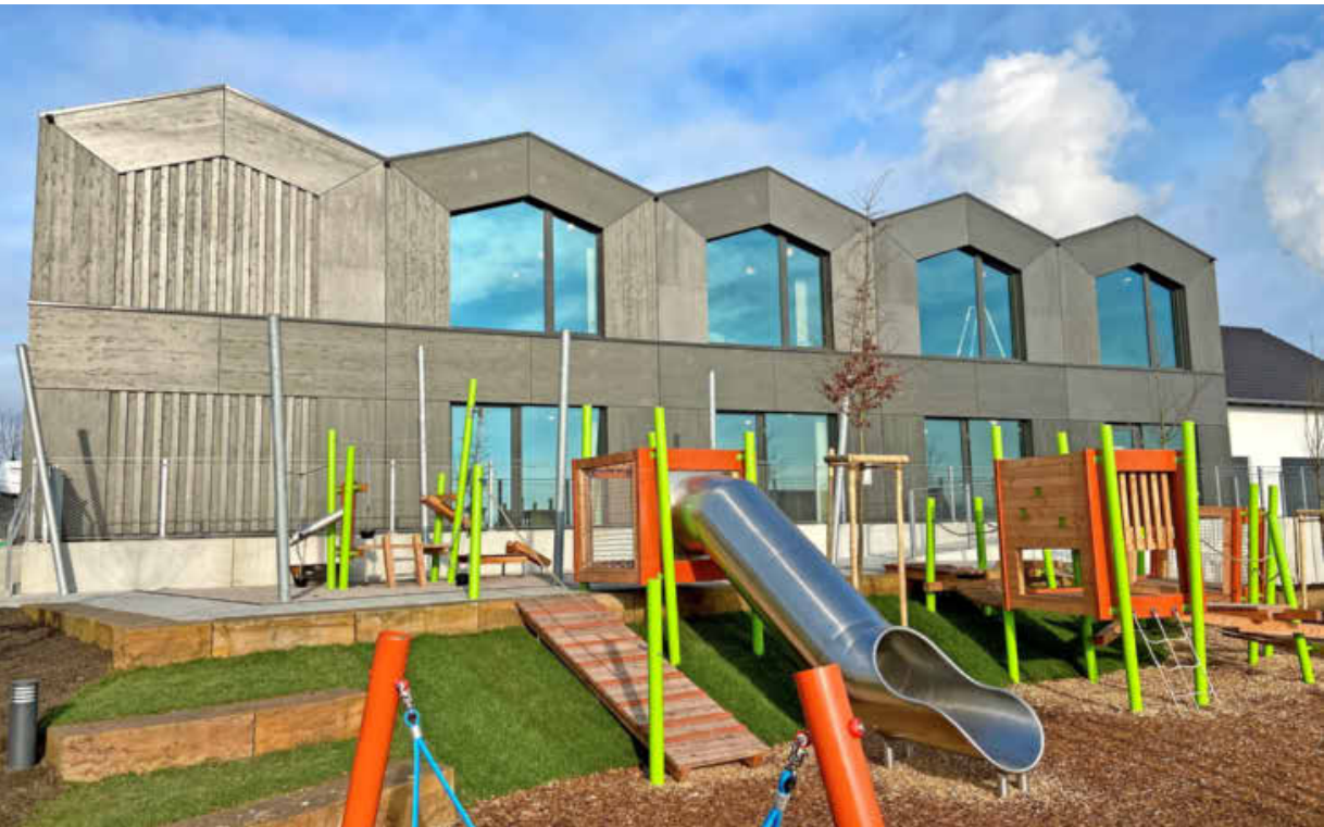
Die Kita Länderlesstraße im Neckargartacher Neubaugebiet Bernhäusle ist die jüngste Kita in städtischer Trägerschaft. Weitere Projekte, etwa in Horkheim und im Badener Hof, sind in Planung. Foto: Zimmerei-Holzbau Heyd GmbH
