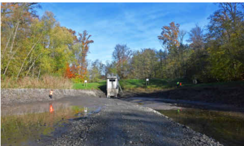
Ohne Wasser im Köpferstausee konnte das sogenannte Durchlassbauwerk mit dem Schieber sorgfältig untersucht werden. Foto: Küpper
