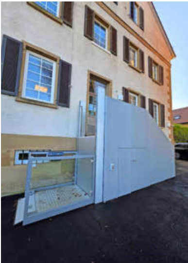
Der Hublift ermöglicht den barrierefreien Zugang zur Bibliothek in Biberach. Foto: Stadt Heilbronn
