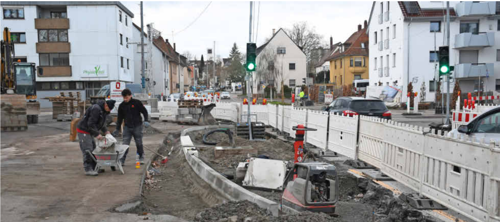
In der Wilhelm-Leuschner-Straße kommt die Großbaustelle mit der Sanierung der Fahrbahndecke nach Ostern zum Abschluss.
