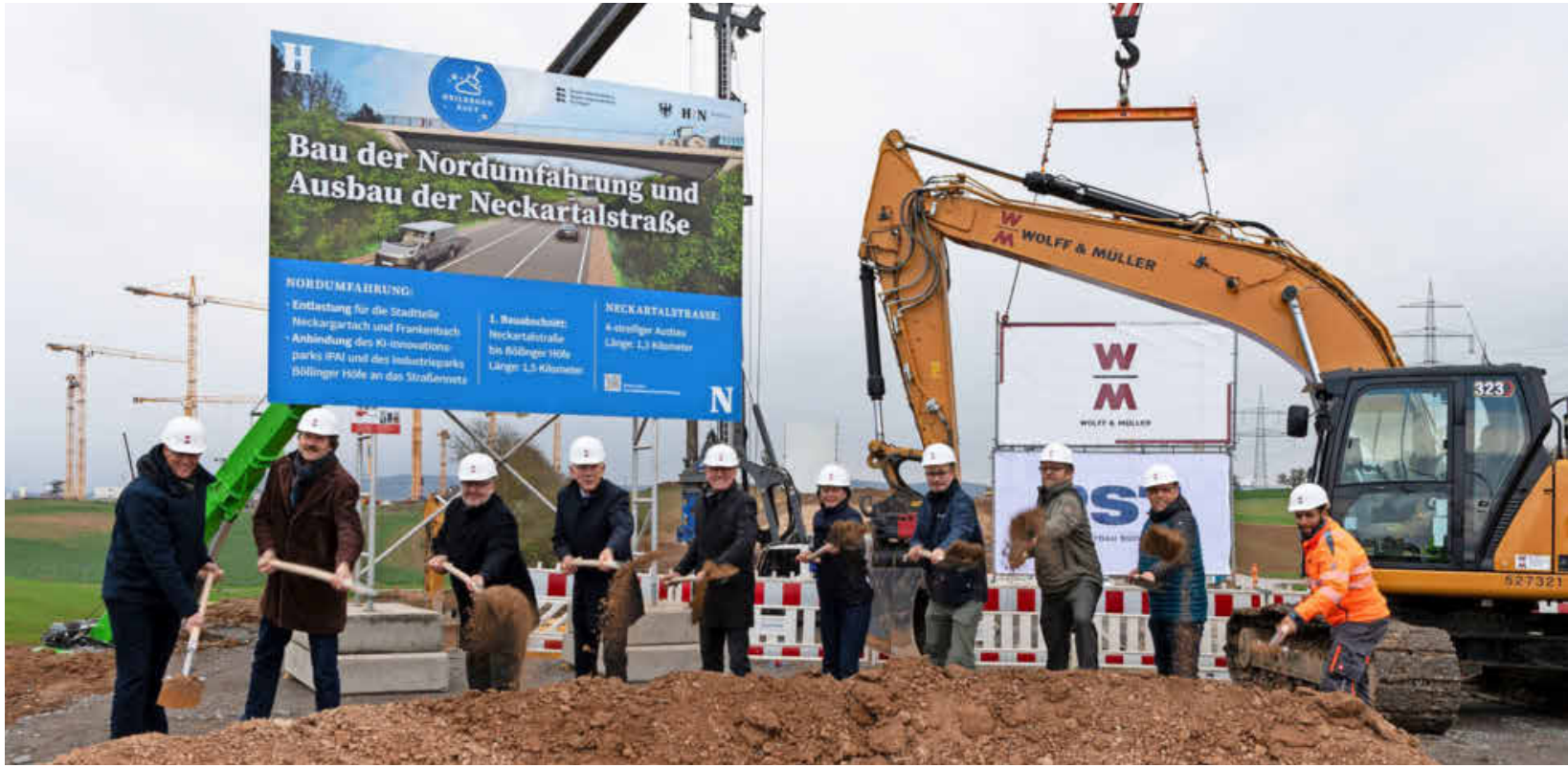
Viele Hände gaben beim Spatenstich den Weg für das Großprojekt Nordumfahrung nördlich von Neckargartach frei.
