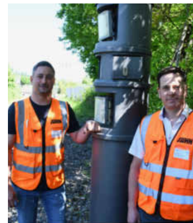
Michael Weller und Roland Kipshoven (Stadtwerke) an der Waggonerfassungsanlage. Foto: Friese
