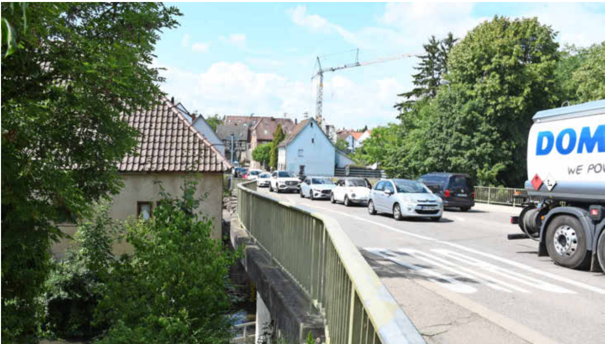
In Frankenbach wird in der Saarbrückener Straße der Belag der Leinbachbrücke saniert. Ab dem 13. Juli ist für rund acht Wochen eine halbseitige Sperrung erforderlich. Foto: Friebe
