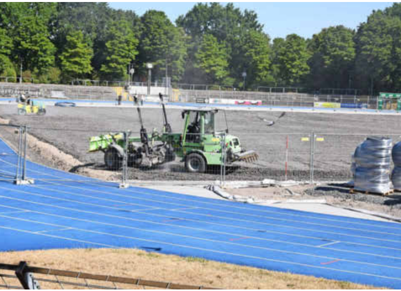
Hier laufen im Frankenstadion Untergrundarbeiten vor dem Einbau der Rasenheizung. Die Frostschutz- und Tragschicht wird verdichtet. Foto: Frieze
