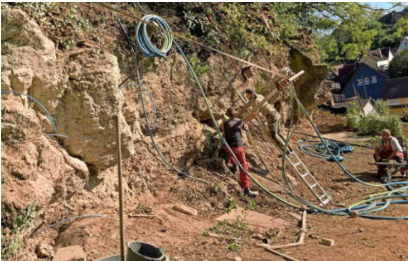
Mit Bohrlafette und Schläuchen für Zementmasse werden die Felsen am Steilhang in Klingenberg stabilisiert. Foto: Stadt Heilbronn/Sadlowski
