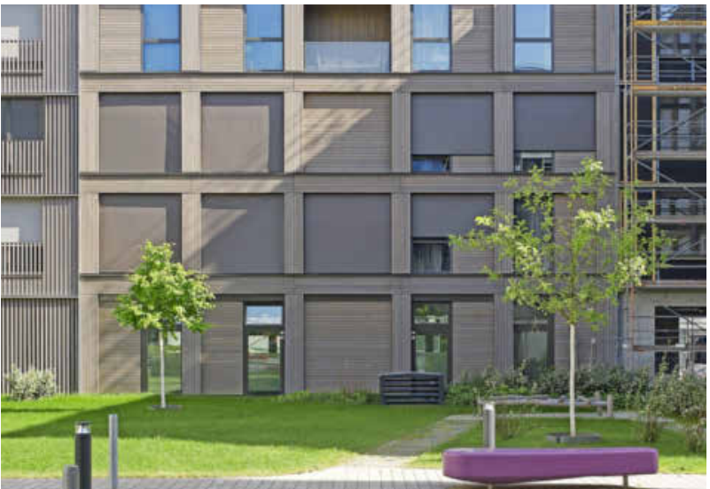
Ebenso prämiert: das Stadthaus K7 im Neckarbogen. Die Jury war von der schlichten, unaufgeregten Art des Baus angetan. Foto: BDA/Achim Birnbaum
