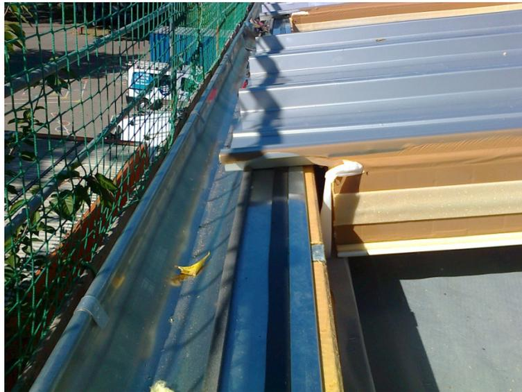
**Bild. I-3:** Beispiel einer Aufsparen-Dämmung mittels Sandwichplatten, Energetische Dachsanierung Grundschule Klingenberg
