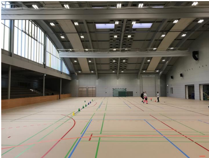
Abb. 18: Modernisierte Beleuchtung mit LED in der Mönchseehalle
