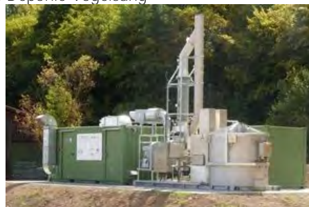
Abb. Xy: Gasförder- und Verdichterstation Deponie Vogelsang
