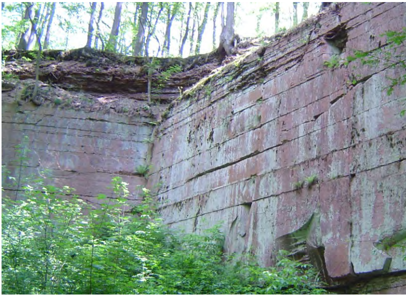
Abb. 3: NSG Schilfsandsteinbruch beim Jägerhaus
