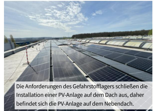
Die Anforderungen des Gefahrstofflagers schließen die Installation einer PV-Anlage auf dem Dach aus, daher befindet sich die PV-Anlage auf dem Nebendach.
