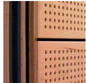
Beispiele für raumakustisch wirksame Bauelemente: Decke eines Büroraums (oben), Wandverteilung einer Sporthalle (unten).
