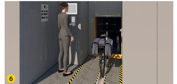
**6** Das Tor öffnet und Ihr Fahrrad wird eingezogen. Sobald das Schiebetor vollständig geschlossen ist, verlassen Sie den Übergabebereich.
