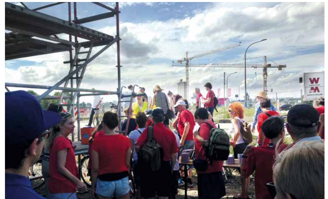
DIE BAUSTELLENFÜHRUNGEN SIND GUT BESUCHT.
