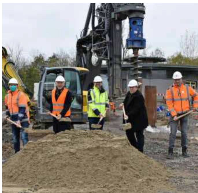
Spatenstich für den Ausbau des Kanalnetzes: OB Harry Mergel (2.v.l.), Bürgermeister Wilfried Hajek (2.v.r.) und HNVG-Geschäftsführer Frank Schupp (M.) mit Vertretern der Baufirmen. Foto: Izquierdo
